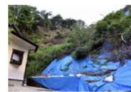
豪雨の度に土砂崩れが多発
